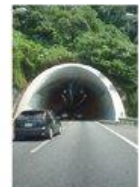
隧道/隧道開頭燈語音提示
