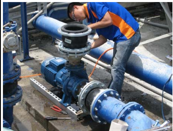
6. 修改出口管路
