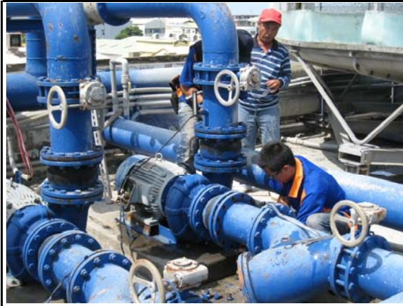
1. 原台製25HP泵浦
