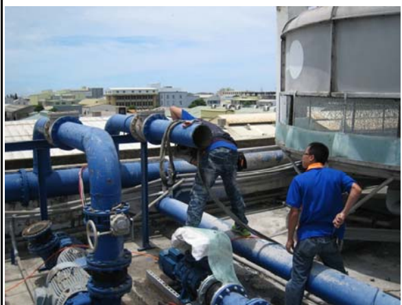
5. 修改出口管路
