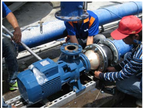
4. 修改入口管路
