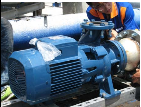
3. 更換Pedrollo 15HP 節能泵浦
