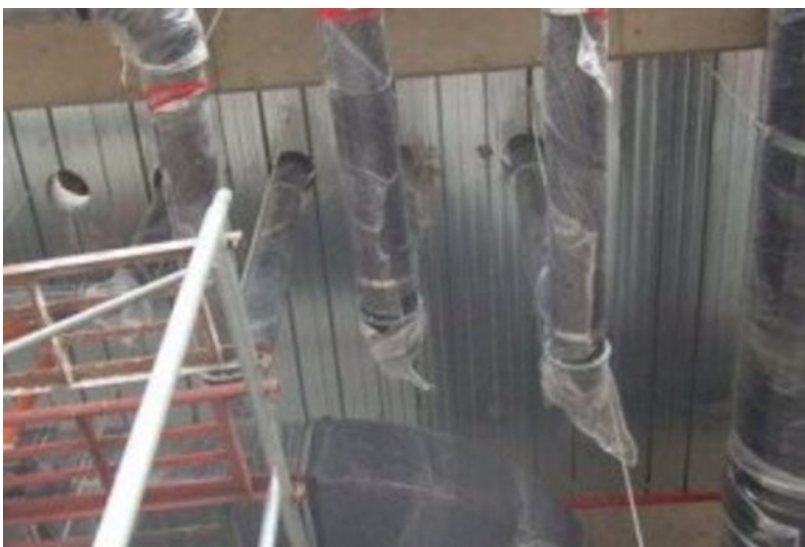
水電、空調、瓦斯等配管之混凝土鑽孔
