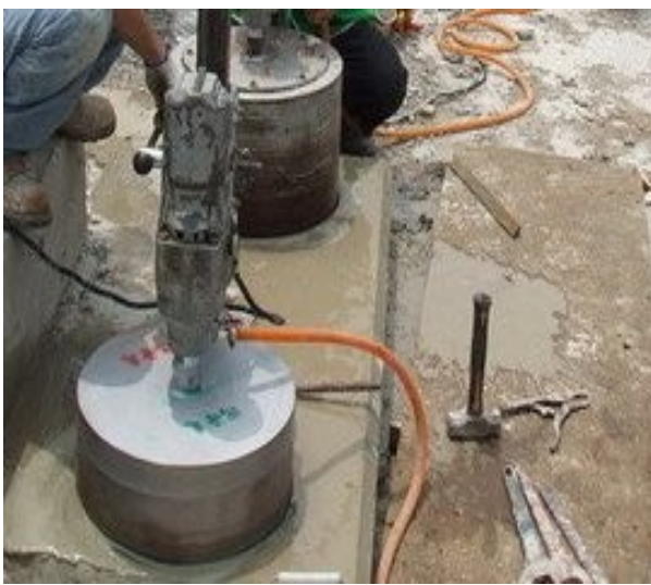
水電、空調、瓦斯等配管之混凝土鑽孔
