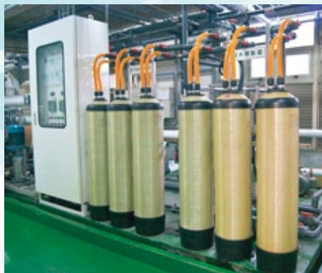
18 mega \Omega 超純水供應系統
