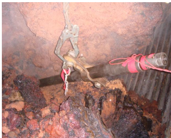
鍋爐內清除結渣
