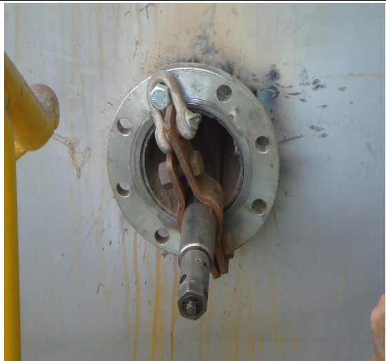
清除煙道管積灰
